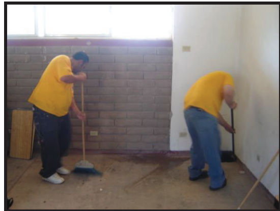
Figura 1-7. Limpieza del piso.
