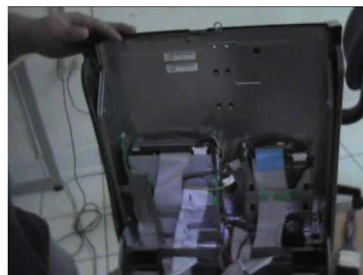
Verificando todos los cables.
