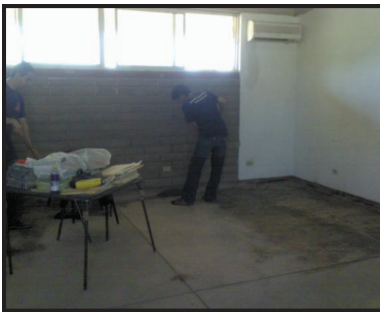
Figura 2-5. Centro de cómputo.
