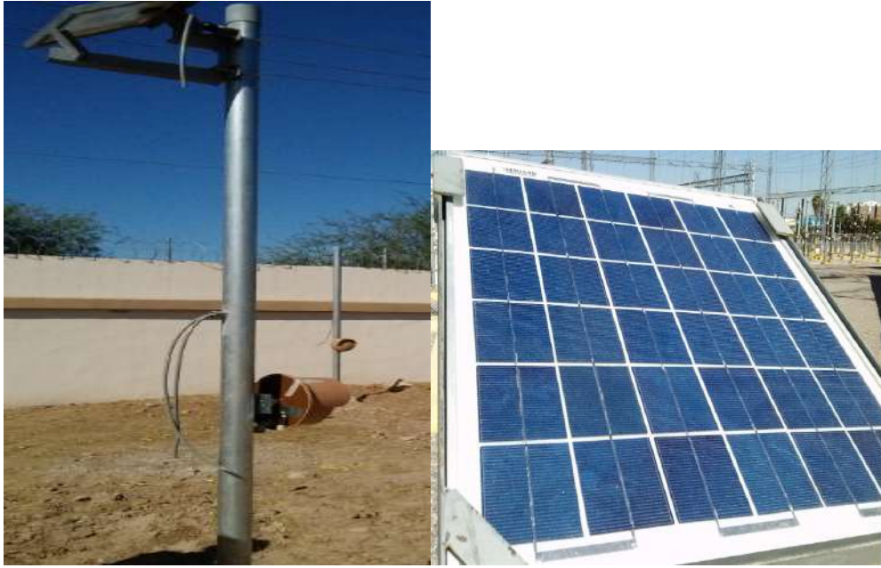
Figura 69. Montaje y soporte de la fotocelda.
