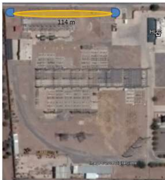
Figura 63. Enlace de 114m.
