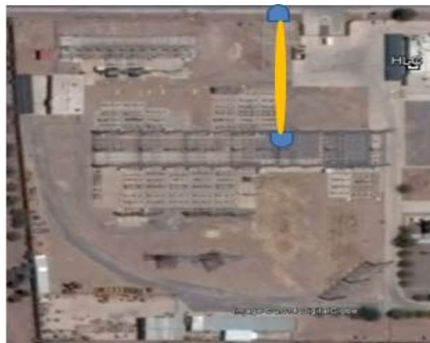
Figura 58. Enlace área 115 y 13.8Kv.
