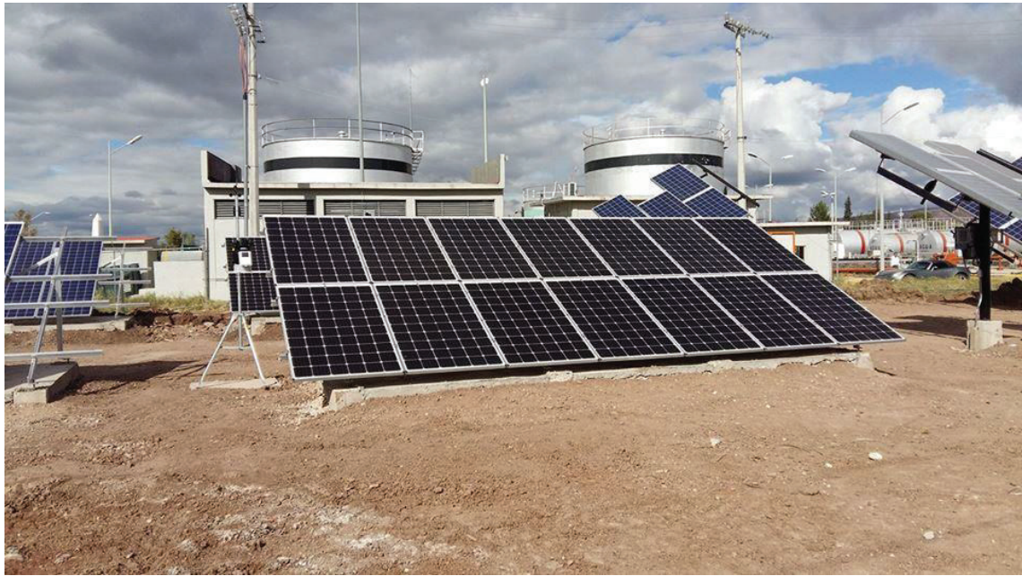
Figura 3.7 Celdas fotovoltaicas monocristalinas (295 watts producidos por cada módulo; Fotografía: Luis Donald Rodríguez Chavarín ).
