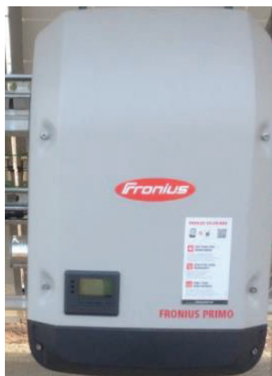
Figura 2.5 Inversor Fronius Primo.
