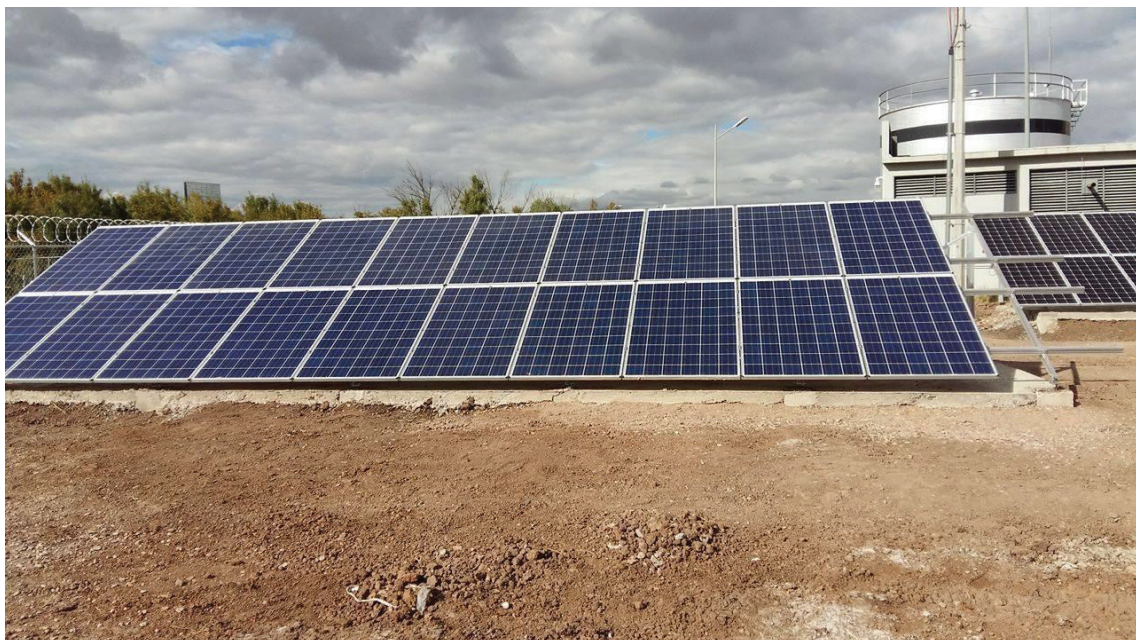
Figura 3.6 Celdas fotovoltaicas policristalinas (250 watts producidos por cada módulo; Fotografía: Luis Donald Rodríguez Chavarín).
