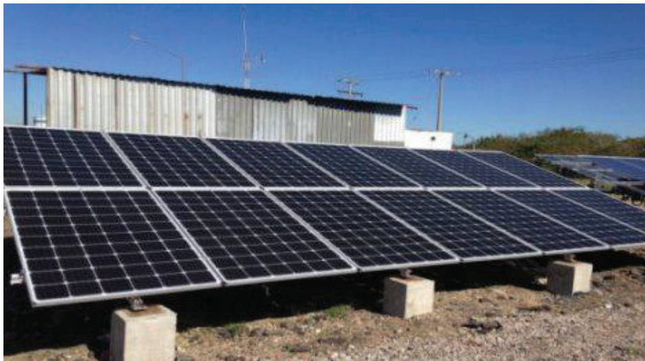
Figura 3.10 Celdas fotovoltaicas monocristalinas (295 watts producidos por cada celda; Fotografía: Impulsor Eléctrico S.A de C.V) [2].
