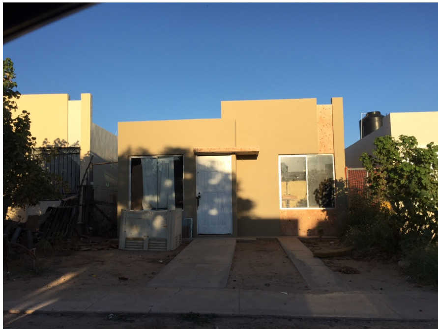
Fotografía 7. Vivienda abandonada, Villa Verde 2017. Fuente propia
