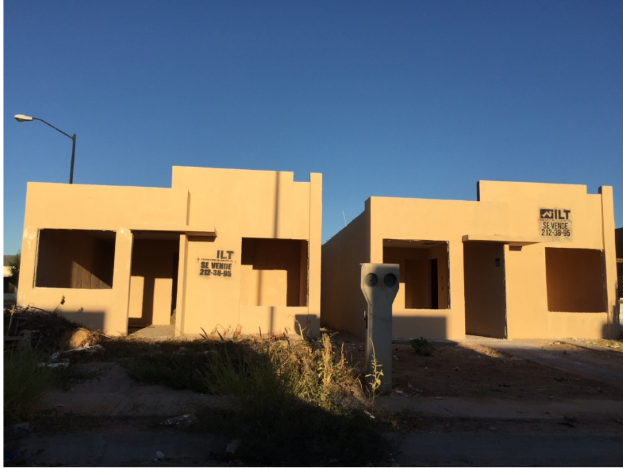
Fotografía 8. Vivienda abandonada, Villa Verde 2017. Fuente propia
