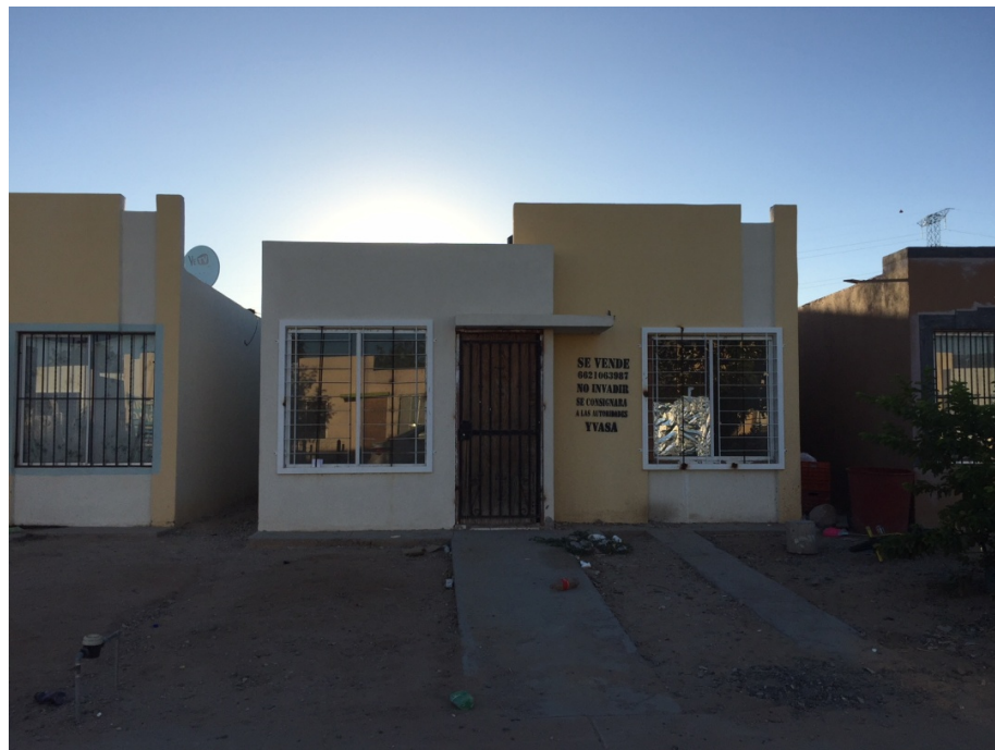
Fotografía 4. Vivienda abandonada, Villa Verde 2017. Fuente propia
