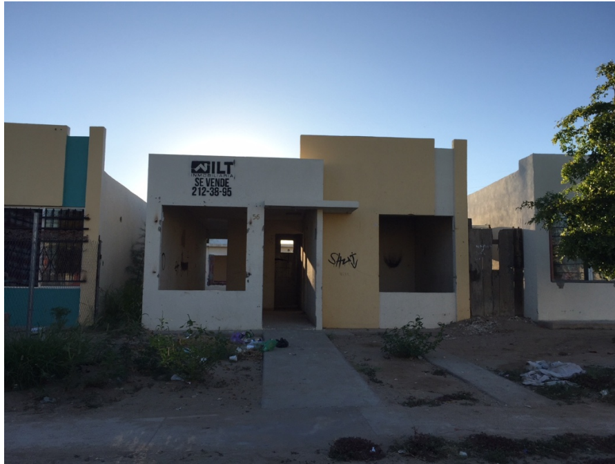
Fotografía 6. Vivienda abandonada, Villa Verde 2017. Fuente propia
