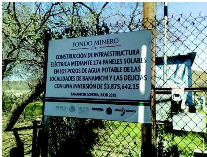
Fotografía 4. Infraestructura eléctrica del pozo
