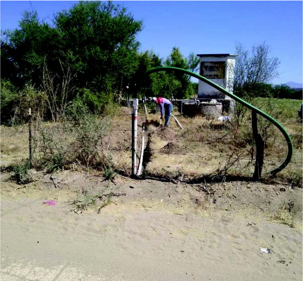
Fotografía 7. Instalación de toma de agua
