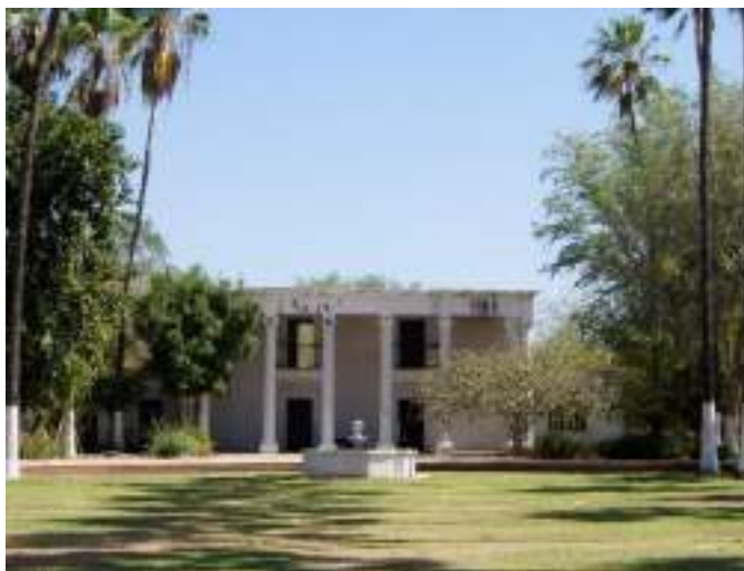
Figura 53. Fachada casa de Las Delicias
