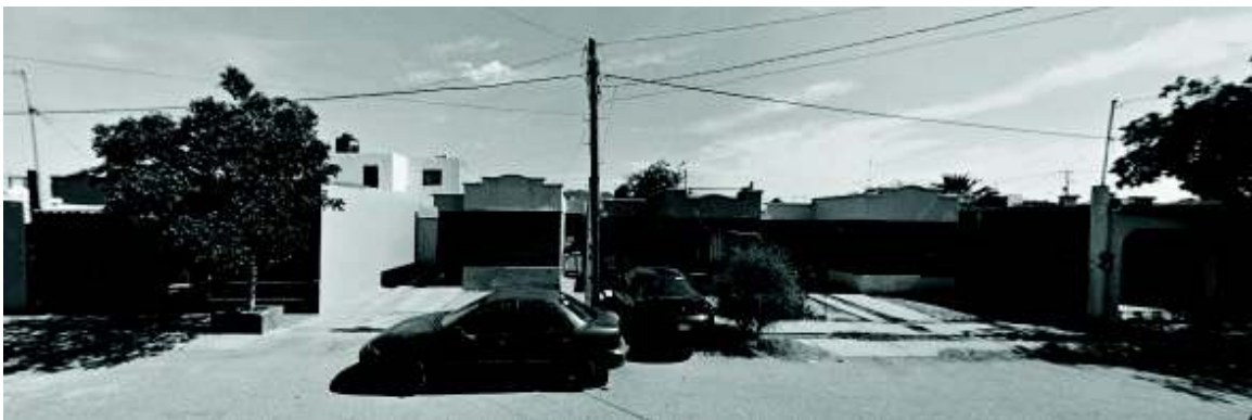
Imagen 6. En la imagen superior en la parte central se observan tres viviendas tipo correspondiente al Fraccionamiento altares, mientras que a los costados se observan las modificaciones realizadas a las viviendas por parte de los habitantes de la colonia, lo cual ha pasado en la mayoría de las viviendas.
