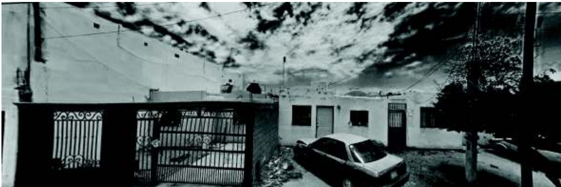
Imagen 8. En la imagen superior se observan dos viviendas del fraccionamiento Altares que han sido ligeramente modificadas, y que aun conservan sus rasgos principales.
