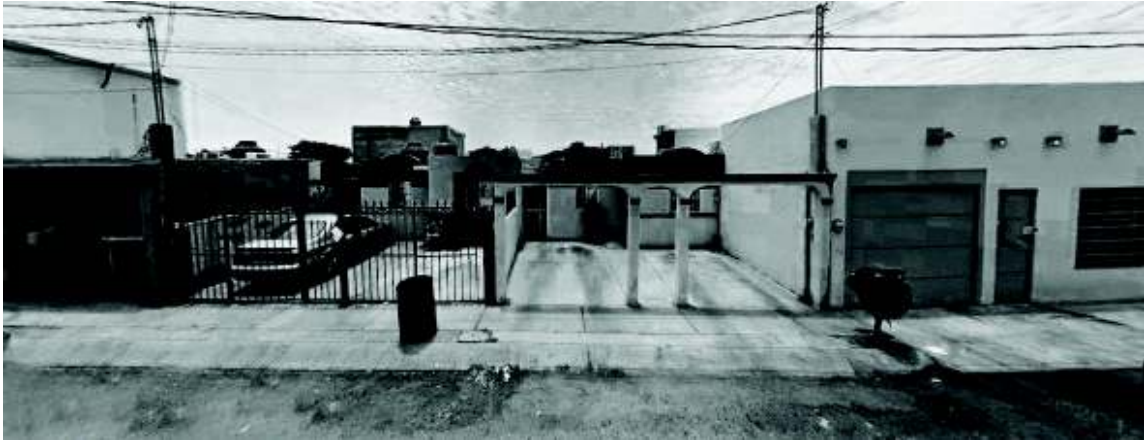
Imagen 7. En la imagen superior al centro se observan dos viviendas que han sido modificadas escasamente cuya remodelación corresponde únicamente al anexo de un acceso y una barda perimetral.
