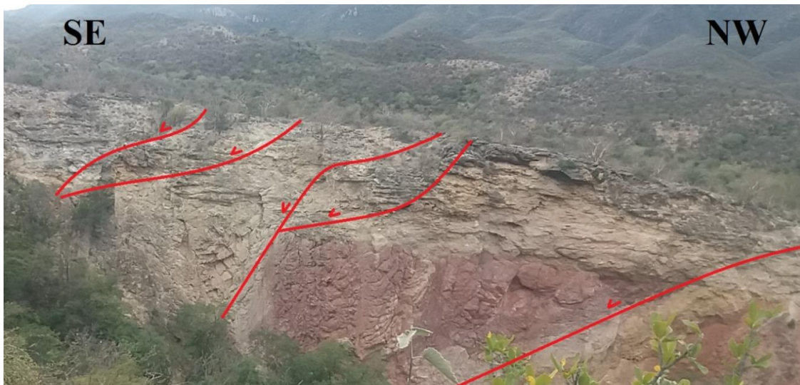
Figura 5.17. Interpretación del fallamiento normal que cortan rocas igneas y sedimentarias del area de estudio. Panorámica observada a unos 80 metros de distancia. La longitud de esta foto es aproximadamente 150 metros.
