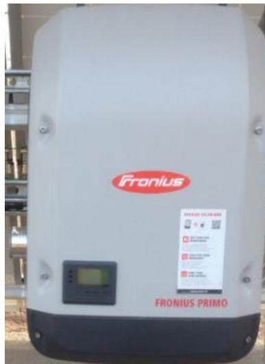
Figura 2.23 Inversor Fronius Primo.
