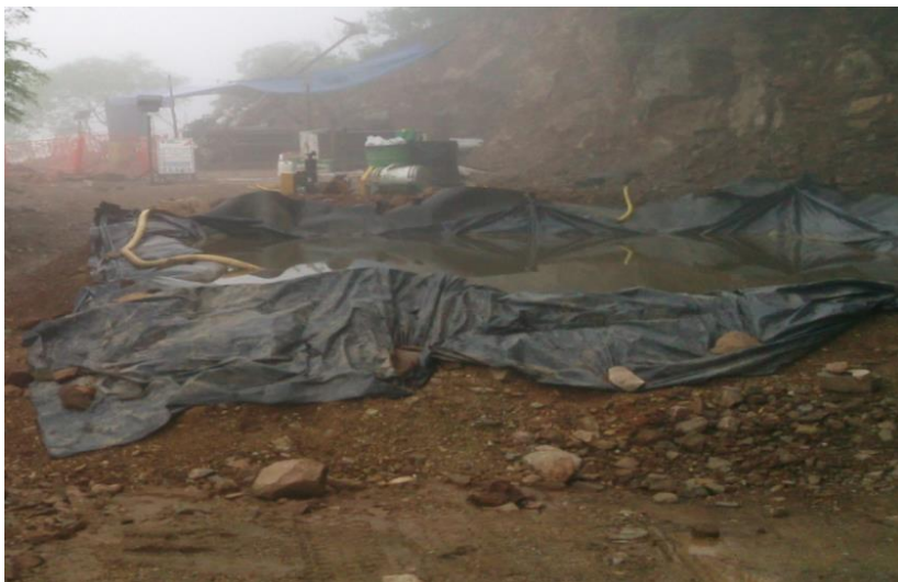
Figura 4. Fotografía mostrando los represas, para contener el agua y usarla en las perforadoras.
