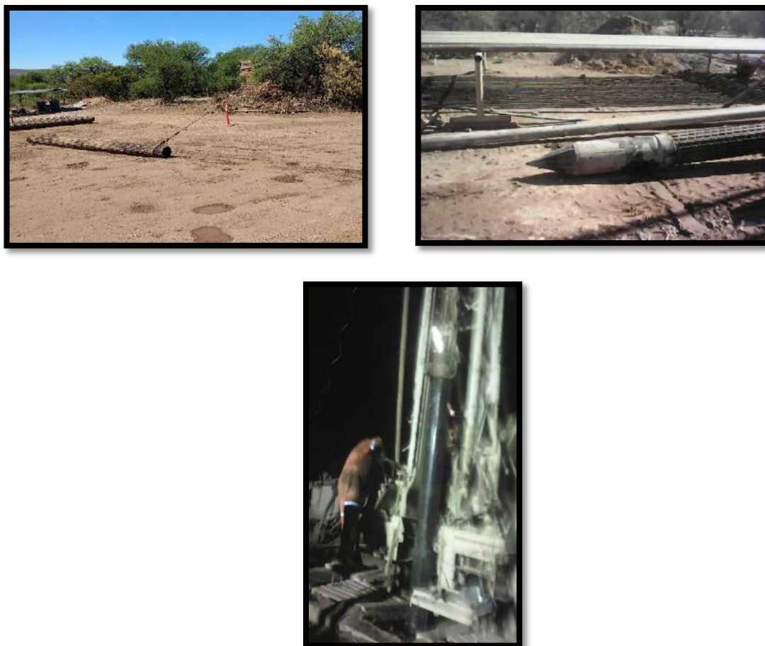
Figura 46. Ademe de 12” de diámetro empleado en pozo TC-06.
