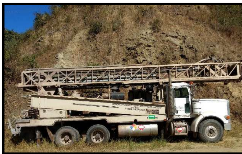
Figura 22. Maquinaria tipo neumática empleada para perforar piezómetro MX-03.
