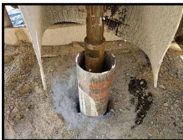
Figura 31. Fraguado de contraademe en piezómetro MX-03.
