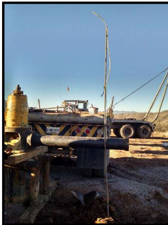
Figura 51. Instalación de la descarga con 6" anillo reductor a 5".
