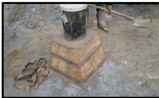
Figura 32. Construcción de brocal en MX-03.
