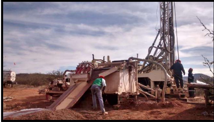
Figura 43. Toma de muestra de lodos para medición de parámetros físicos TC-06.
