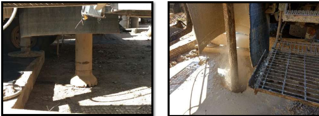
Figura 30. Inicio de perforación martillo 7 1/4" de diámetro para colocación de contraademe.
