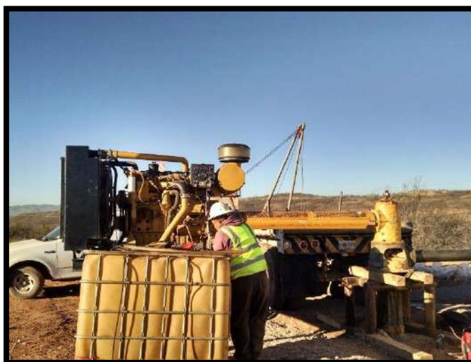
Figura 49. Instalación de equipo para aforo de pozo TC-06.
