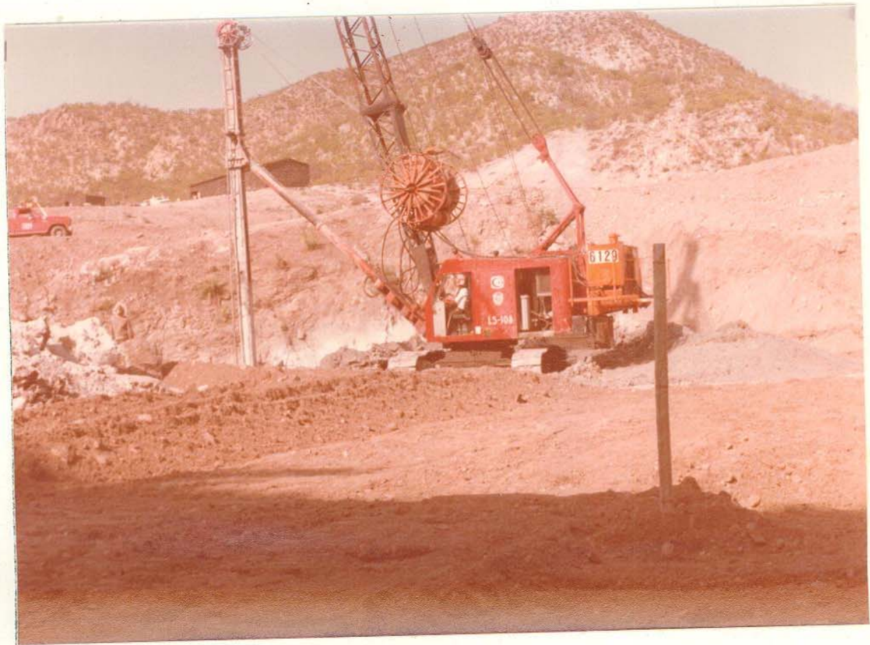
F.22.- Obsérvese en primer plano un piezómetro y al fondo construcción de Pantalla Flexible.
