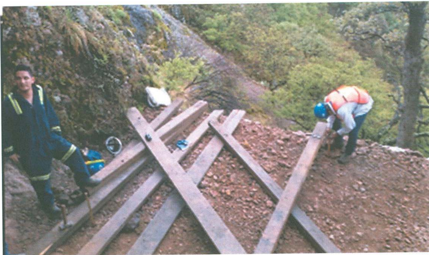
Figura 7.- Generación y adecuación de una planilla para barrenación.
