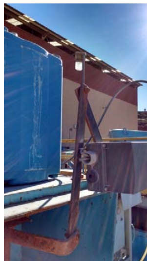
Figura 21. Posicionadores y abrazaderas nuevas en el Banco 1.
