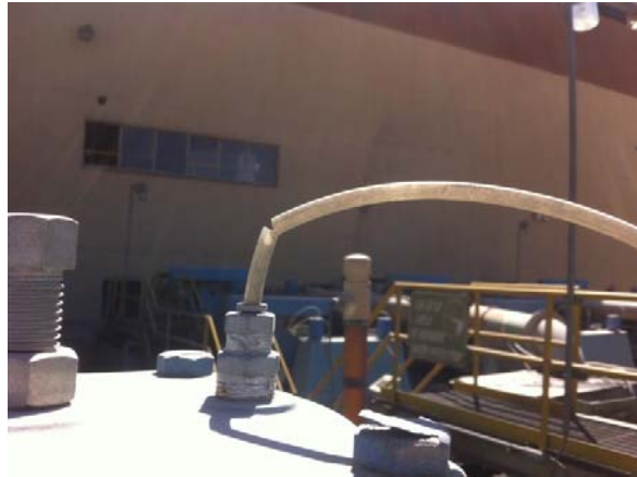
Figura 22. Mangueras transparentes endurecidas por el sol y destrozadas.
