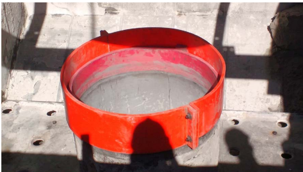
Figura 26. Cambio de anillo de sumergencia, draft-tube y piso falso.
