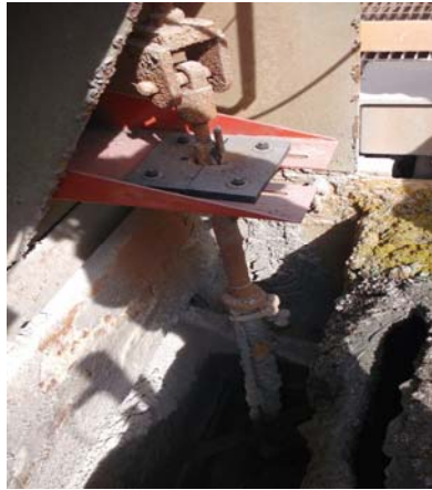
Figura 18. Guía superior adaptada para el buen embone del dardo.
