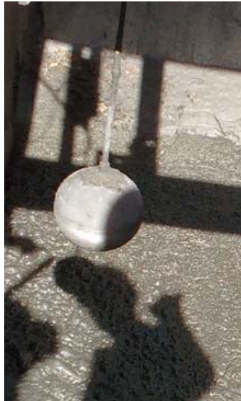
Figura 20. Bola de nivel limpia con ácidos para el despojo de solidos incrustados
