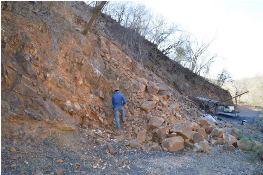
Figura 24. Detalle del deslizamiento de rocas en el sitio San Agustín donde se puede apreciar los bloques de rocas deslizados interrumpiendo el camino.
