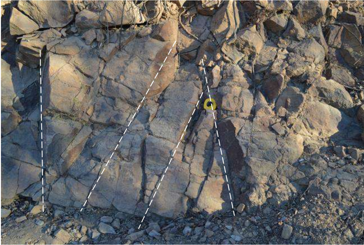
Figura 3. En este afloramiento del sitio Mina Sentimiento 1, se identifican dos tipos de familias principales de fracturas.
