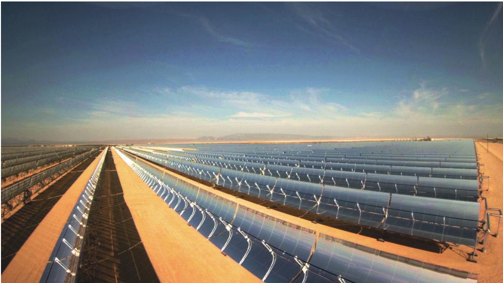
Figura II.7 Parte del complejo solar de Mojave. Fuente: National Renewable Energy Laboratory
